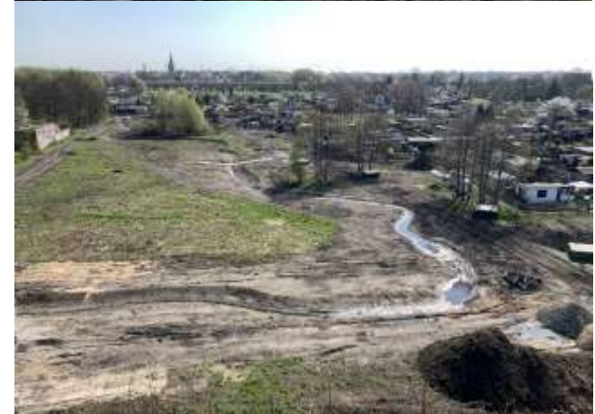
Abb.9 u. 10: Geländeherrichtung und Bauphase (Fotos Stadt Leipzig)
