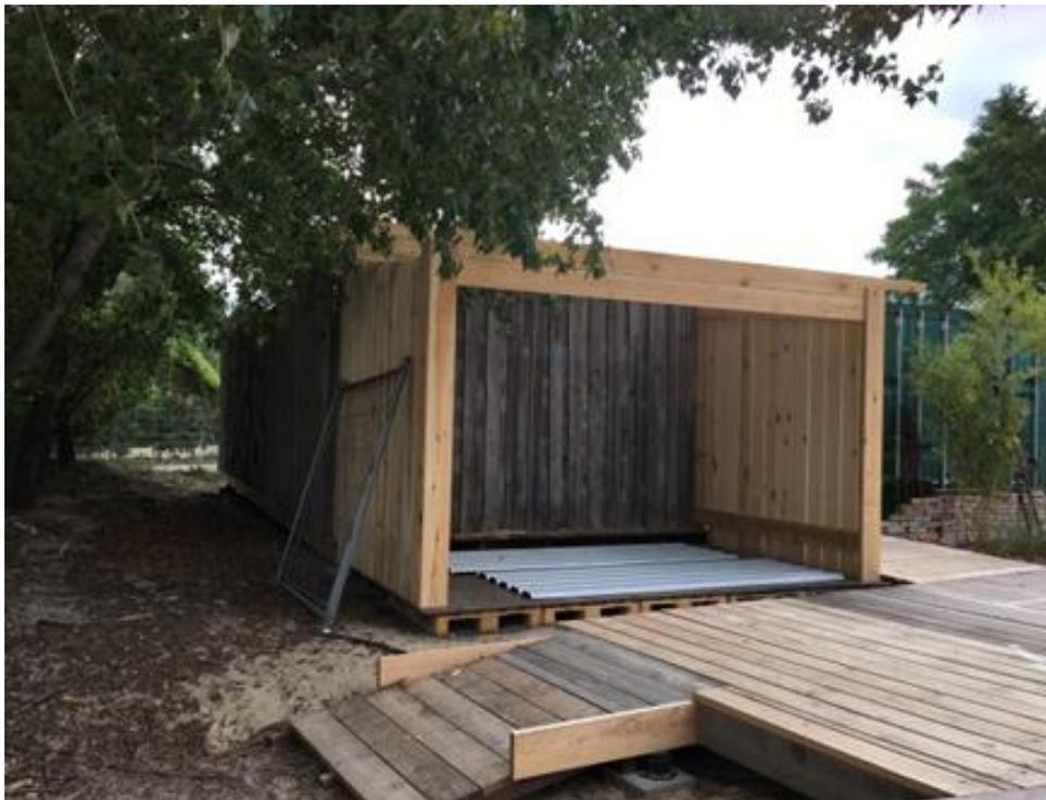
**Abbildung 5: Bau einer Einhausung als vorbereitende Maßnahme zum Aufbau der Grauwasseraufbereitungsanlage. Foto: Gregor Weise**
