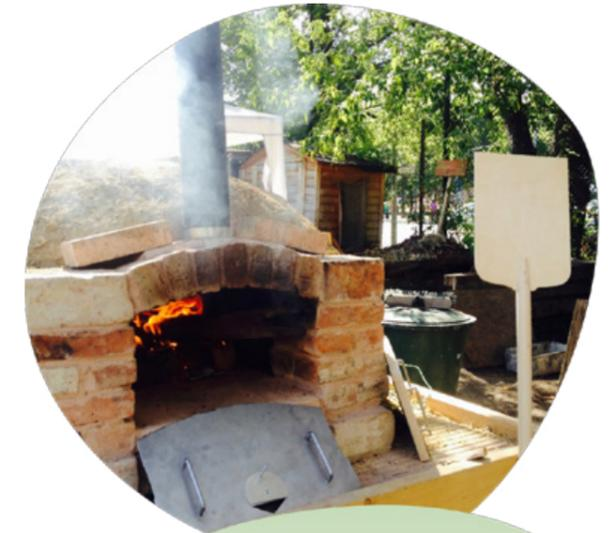
Bei 450 °C kann der selbstgebaute Ofen Pizzen backen, später bei circa 250 °C ist es Zeit für Brot. Die Restwärme eignet sich, um Gartenkräuter für Teemischungen zu trocknen.
